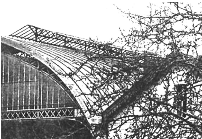
Marquise de la gare de Bédarieux Coupe transversale côté nord Le lanterneau et le rideau vitré. (fragment d'une carte postale du début du 20 e siècle )
