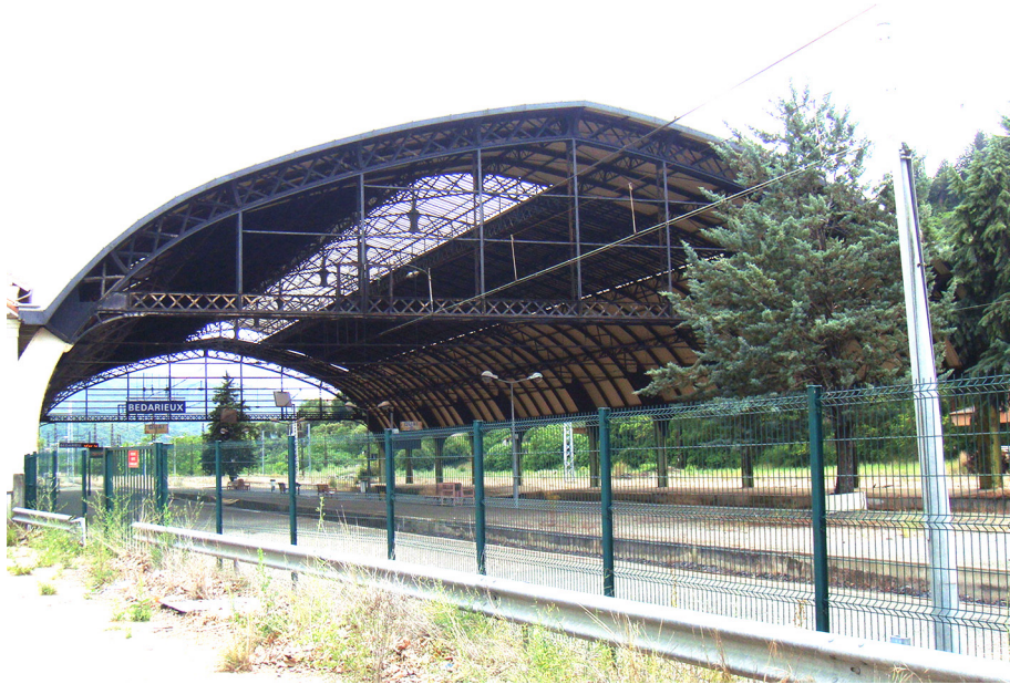
Etat actuel, côté nord. (Photo Y.S.)
