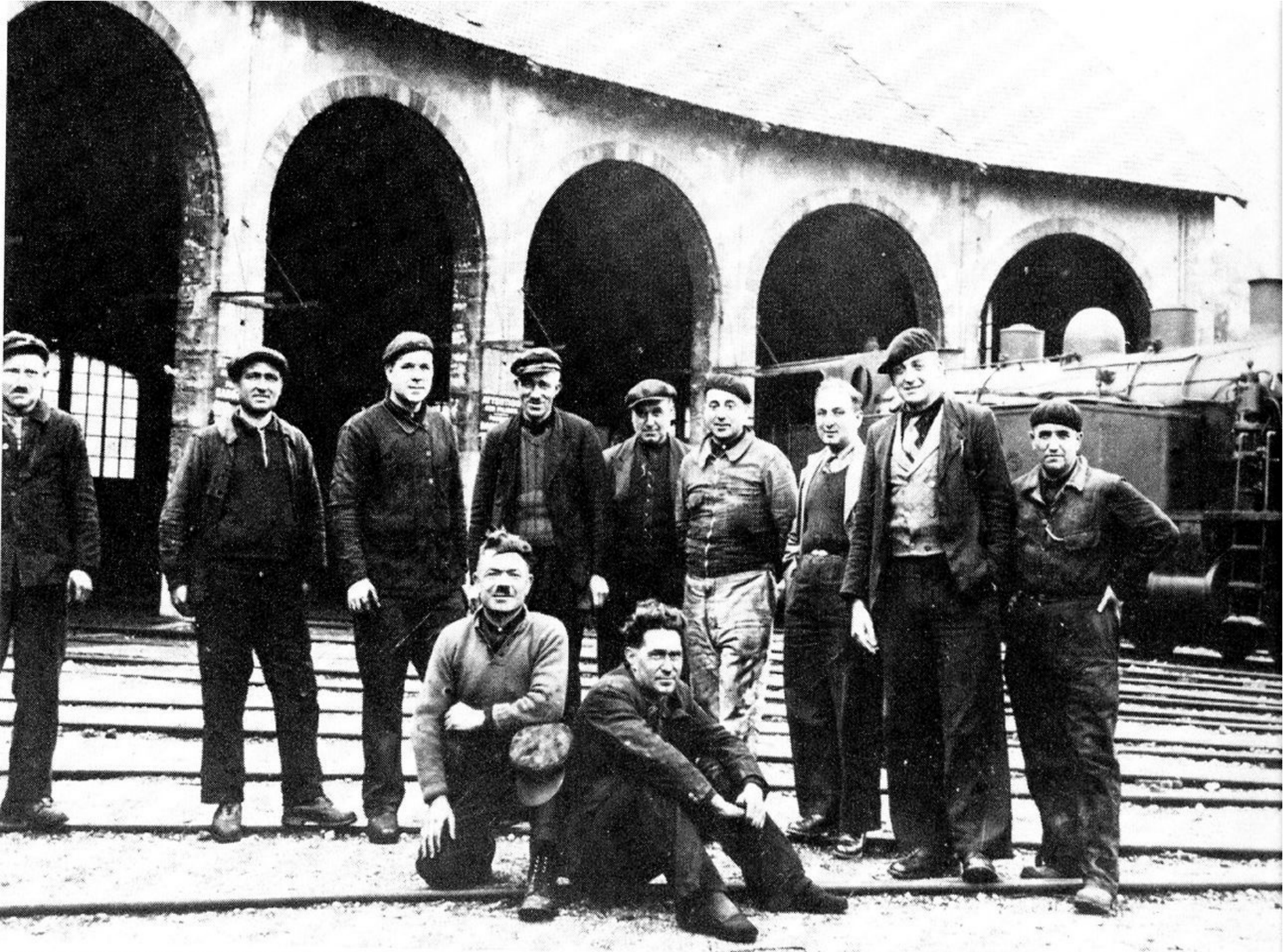
Quelques cheminots au dépôt des machines de Nissergues
